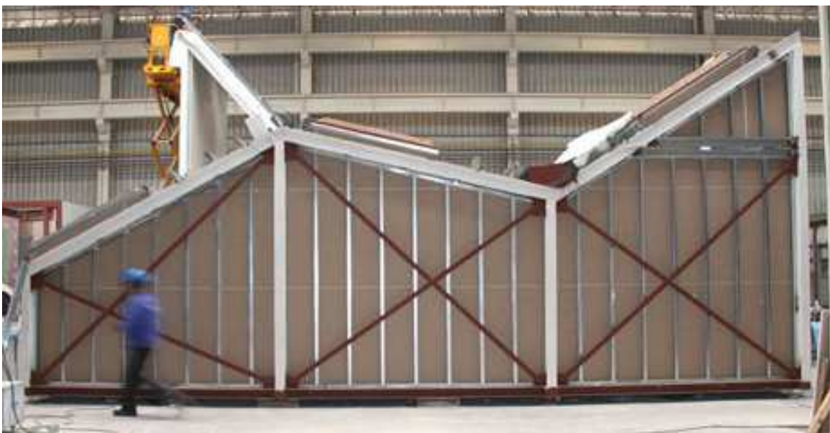
Struttura in acciaio, solaio a pavimento in lamiera grecata e getto collaborante
