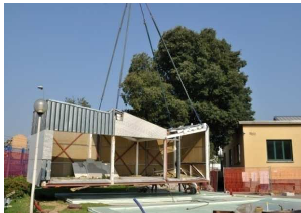
VELUXlab: inizio del cantiere
